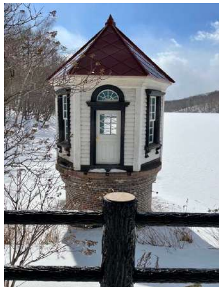
国登録文化財の取水塔
